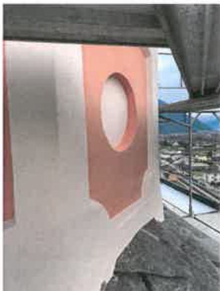
L'impresa di pittura ha dapprima consolidato il fondo, applicato un nuovo intonaco fine a base minerale, e da ultimo ha proceduto al tinteggio
