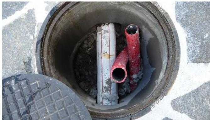
*Figura 18 - Illuminazione pubblica dettaglio pozzetto rete esistente*
