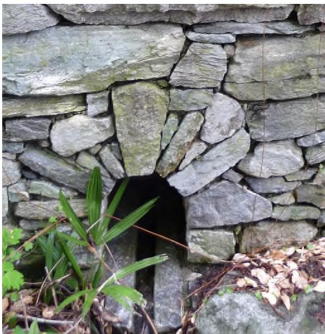
Figura 15 - Drenaggio a tergo del muro esistente
