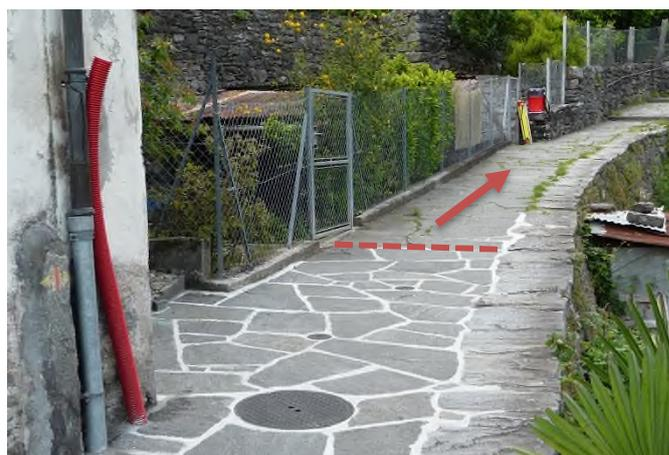
Figura 12 - Limite d'intervento posa canalizzazione acque luride
