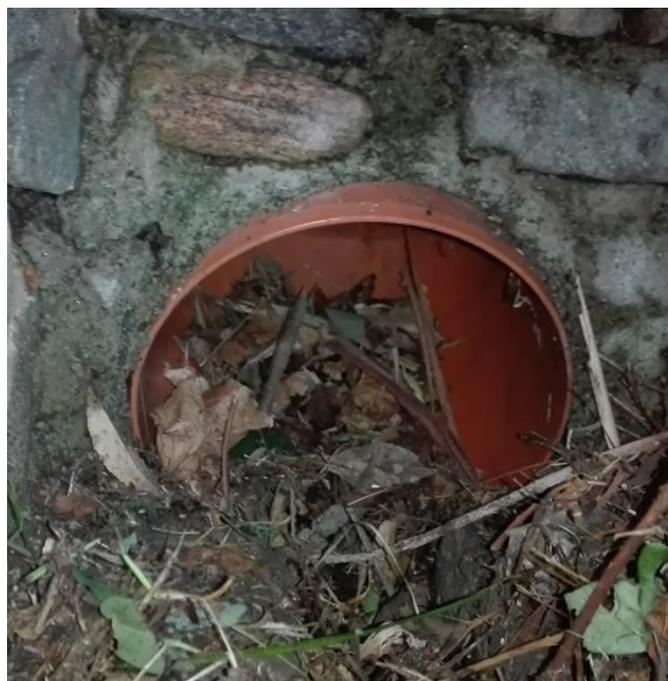
Figura 16 - Drenaggio a tergo del muro esistente
