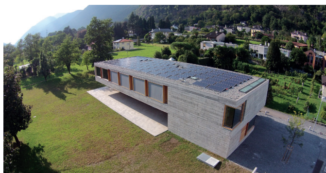
Fig. 1: Fotovoltaico sul tetto delle SE a Tegna
